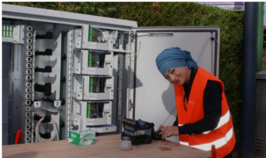
Durak Rumesysa réalise des milliers de soudures sur les fibres optiques avec du matériel très performant et les scanne systématiquement pour garantir le zéro défaut.
